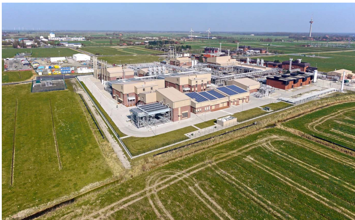
Abbildung 1: Blick auf die Gasspeicheranlage der EWE in Nüttermoor nach dem Ausbau.
